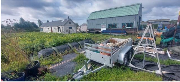
Foto 9: Locatie vanuit noordoosthoek richting het westen. Opslag van tuinmateriaal en planten in potten op worteldoek. Bestaande woonark wordt verwijderd.
